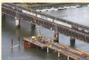
Pont sur l'Adour à Bayonne (jet grouting)
