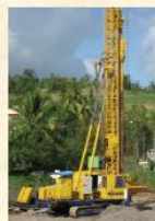
Antilles (colonnes ballastées)
