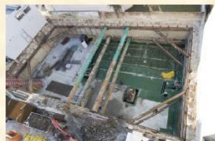
SCI Atland, Le Vésinet (paroi en Deep Soil Mixing)
